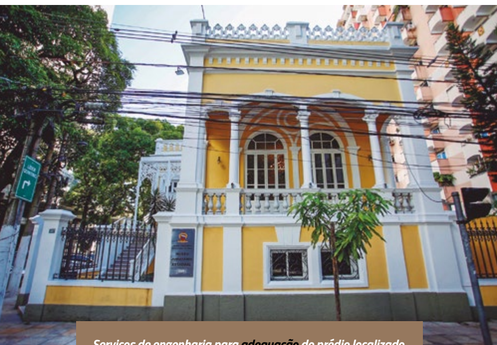
Serviços de engenharia para adequação do prédio localizado na Av. Nazaré, em Belém, destinado ao funcionamento da Casa de Justiça e Cidadania, Ouvidoria da Mulher, Ouvidoria Judiciária, Museu Judiciário e serviços de apoio.
