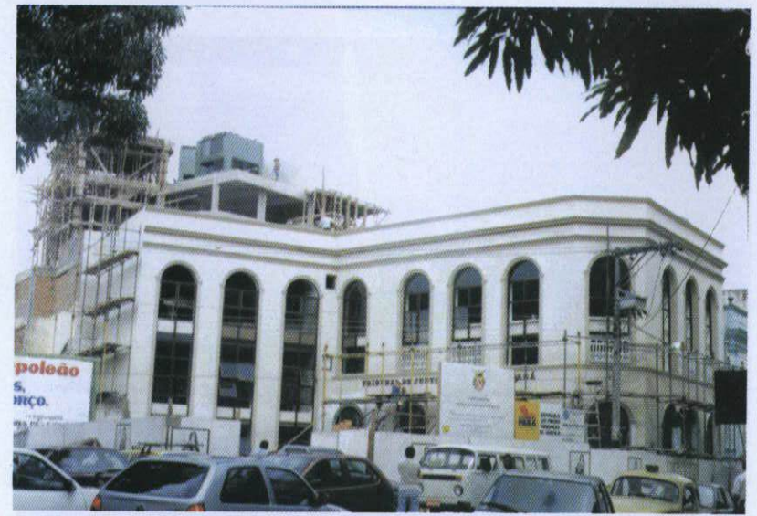
Prédio da Repartição Criminal recuperado e inaugurado na administração do Presidente Manoel de Christo Alves Filho
