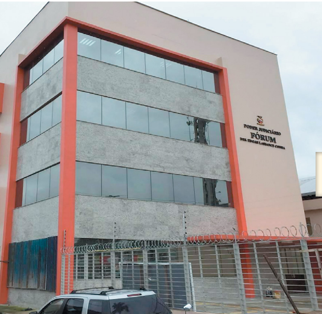
Bloco I do Fórum de Ananindeua
