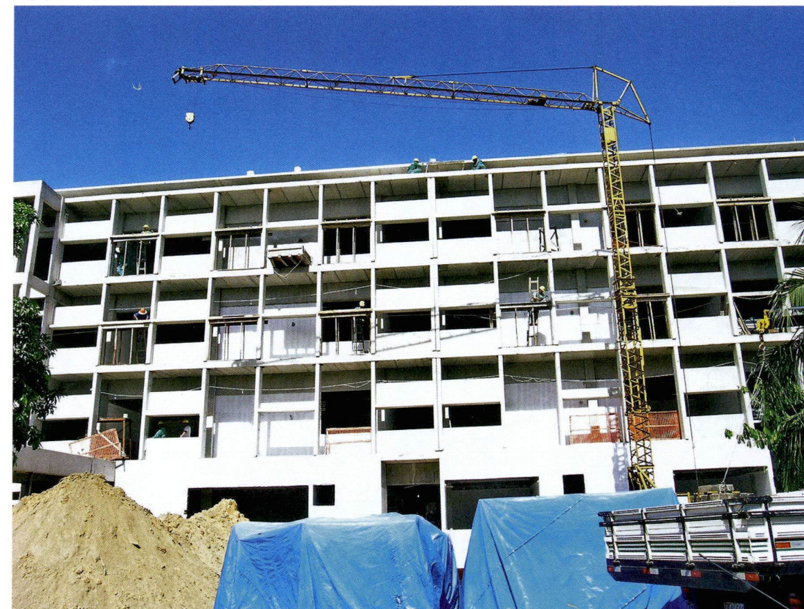
Fig. 31 - Aspecto da construção do prédio anexo
