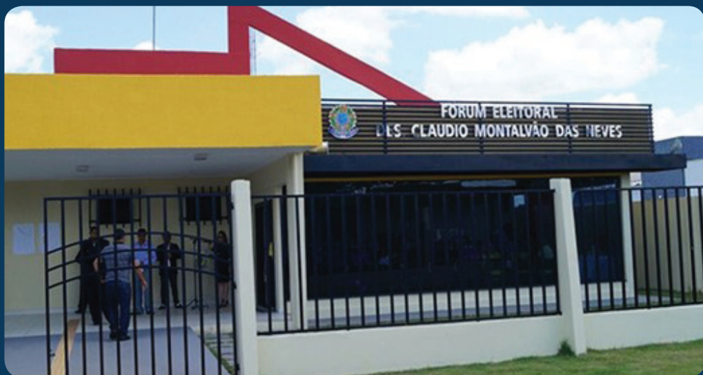
FOTO 48 - Fachada do Fórum Eleitoral.
